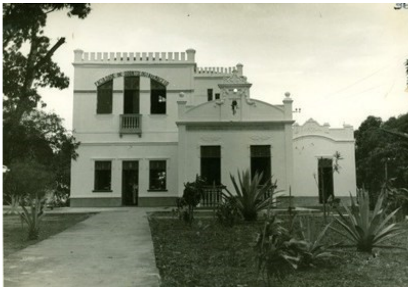
Figura 1- Prédio da antiga faculdade de Odontologia
